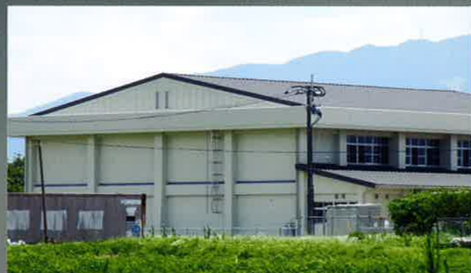
福田小学校体育館 / 福岡県
