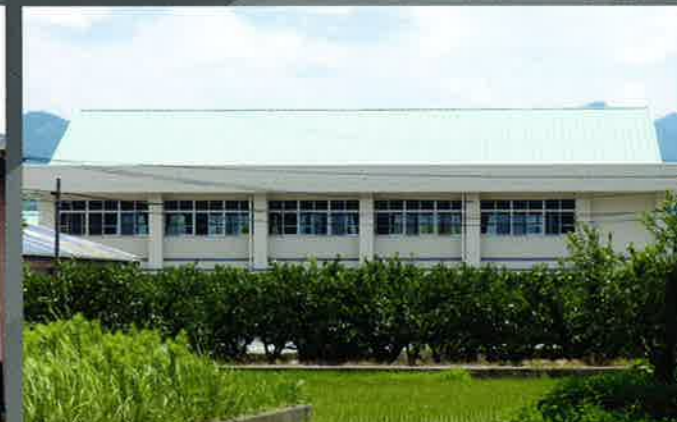
久喜宮小学校屋内運動場 / 福岡県
